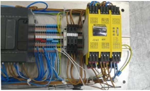
Bild 2: Die Steuerungseinheit der neuen PUMA-Brottschneider. Rechts im Bild: die Sicherheits-Kompaktsteuerung PROTECT SELECT OEM.
